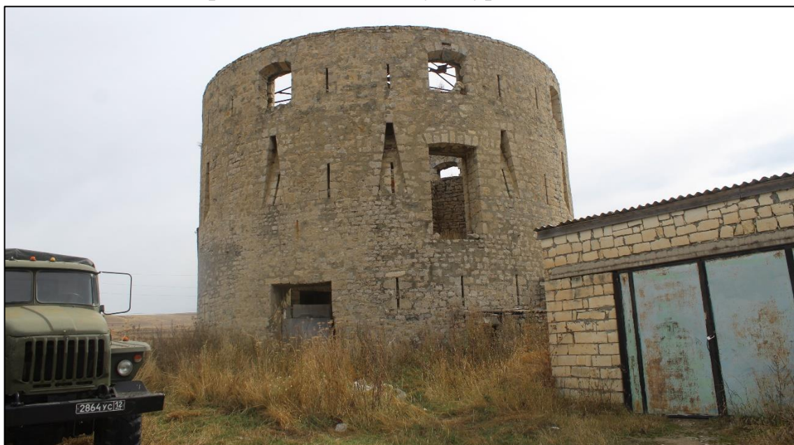
Фото 1. Вид на сторожевую башню с бойницами с западной стороны. (Фото предоставлены Агентством по охране объектов культурного наследия Республики Дагестан. Дата снимка 13.10.2022 г.)
